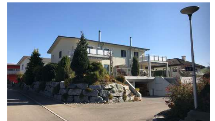
Hohe Böschung und Stützmauer; keine Interaktion zur Strasse
