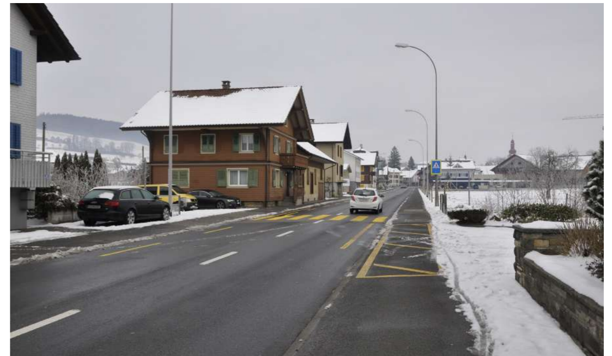
Teilgebiet I: Underdorf. Blick in Richtung Dorfkern. Ortsbaulich wertvolle Gebäudestellung zur Strasse hin
