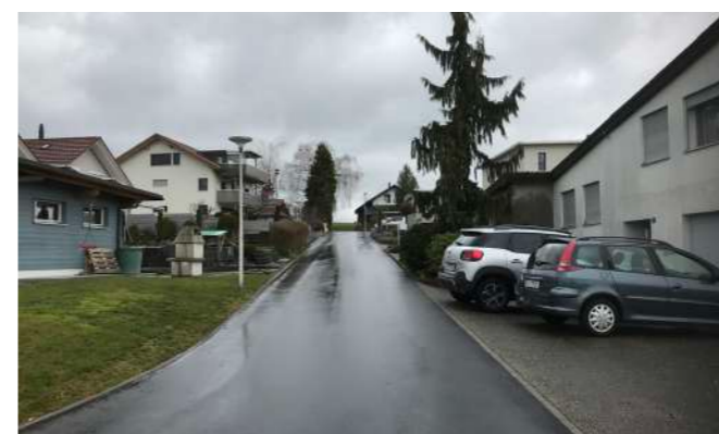
Erschliessungsstrasse entlang Schnittstelle Teilbereich II & III
