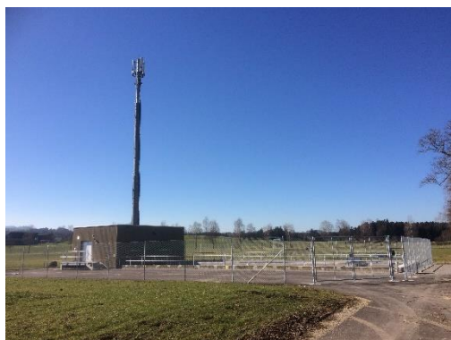
Neue Pumpstation mit zwei Regenbecken
