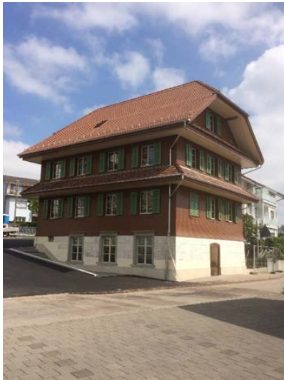
Sanierung Lehrerheim Schulhausstrasse 13
