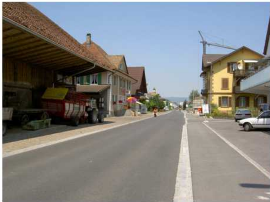
Abbildung 8: Muhen AG, Beispiel für eine Ortsdurchfahrt mit Rinnen und fehlender Mittelmarkierung.
