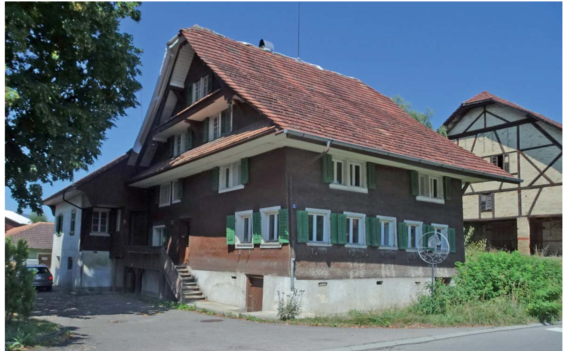
"Gasshaus" - Schulhausstrasse 3, 6018 Buttisholz
