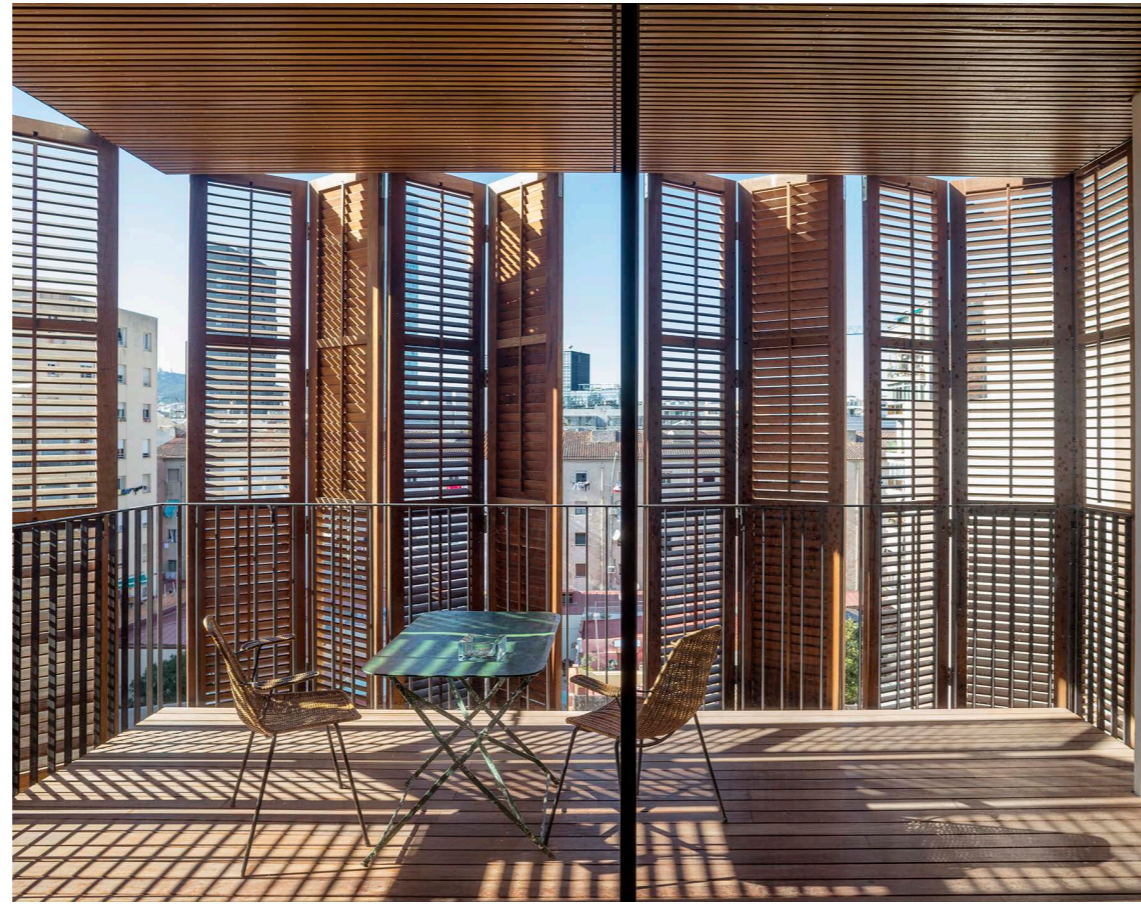
Chrüzschüür: Faltbare Jalousien als Lärm- / Sichtschutz
