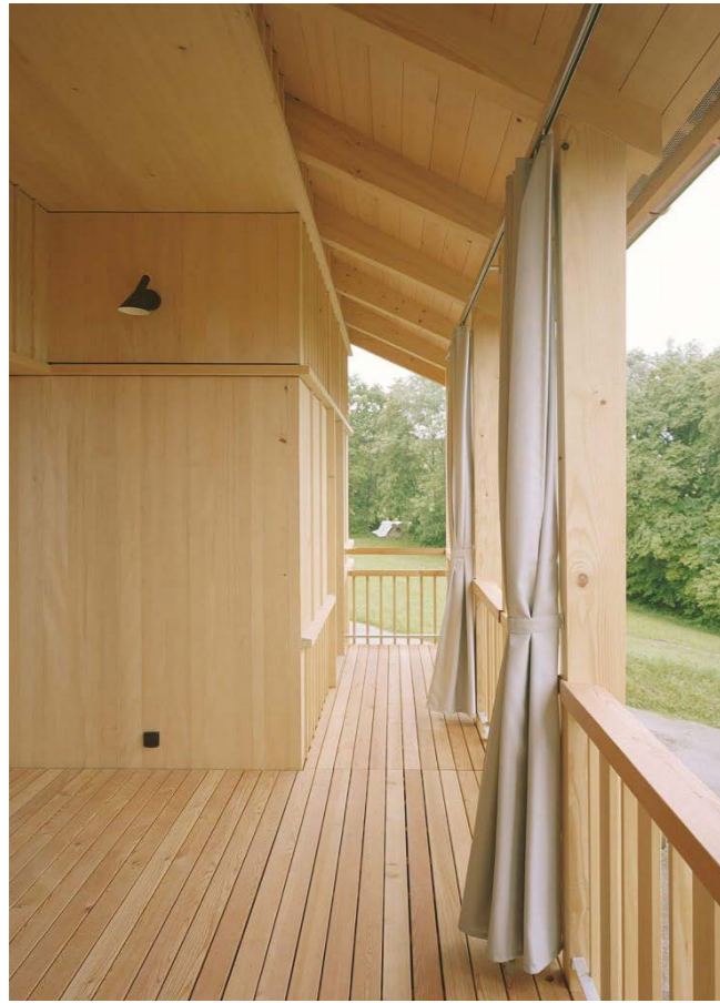
Chrüzschüür: Verweise auf landwirtschaftlich traditionelle Bauweise
