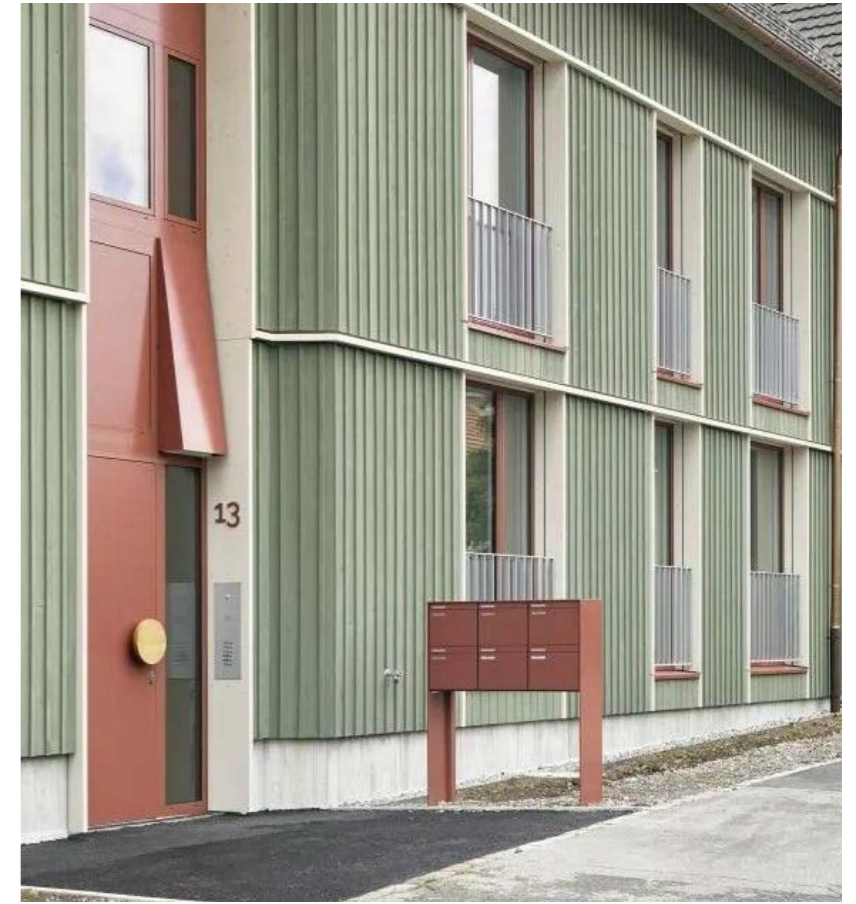
Chrüzhus: Bezug zu Bauten zweiter Reihe (Holzbauten)
